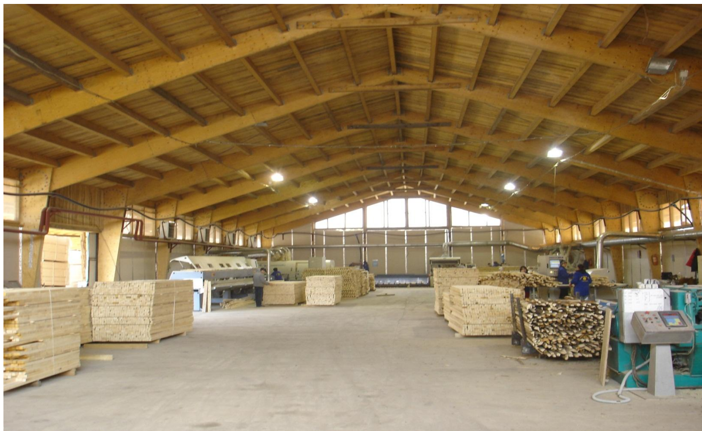
Hala semifabricate 2 (vedere interioară)
